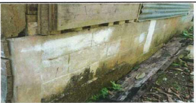
Foto 5: Sustrucción de Pared
