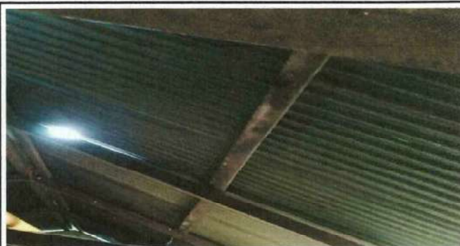
Foto 2: Sustrucción de madera por metal.
