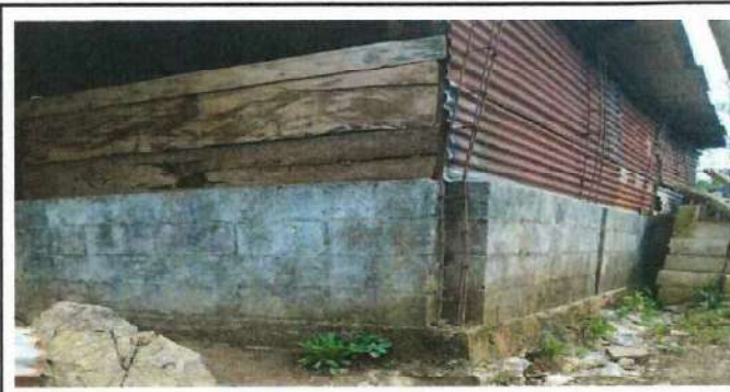
Foto 4: Rehabilitación de pared.
