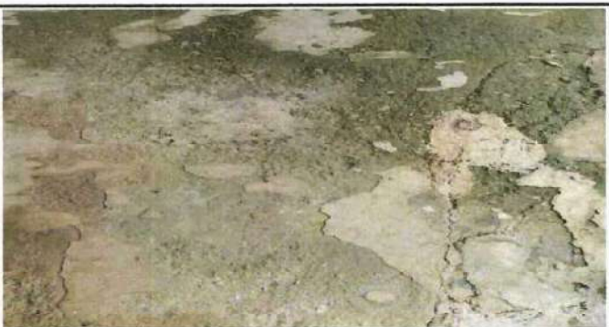
Foto 3: Sustrucción de piso.
