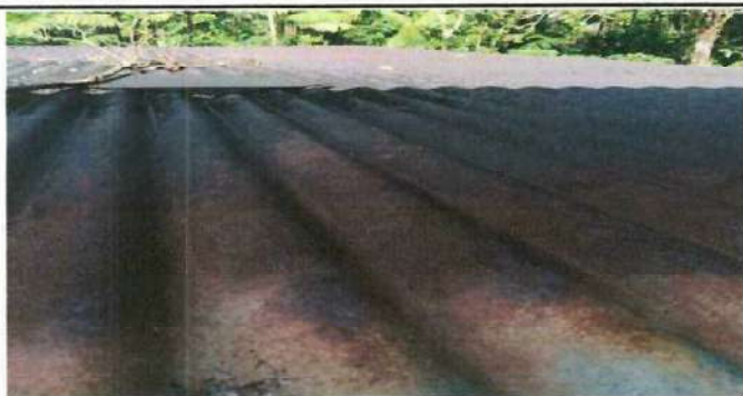
Foto 1: Sustrucción de estructura de techo.
